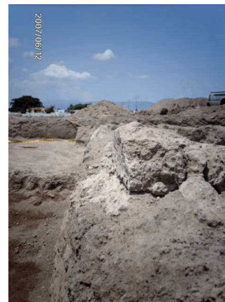
Imagen 9.- Detalle de acabado y desplante de muro.
